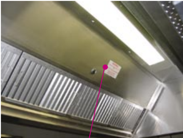
ZUGANG ZUR UV-LAMPE
